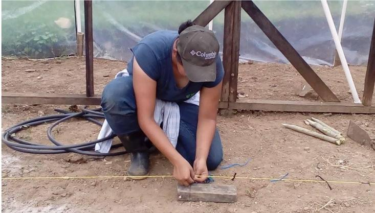
Figura 6. Alineado de los surcos para instalación del sistema de riego por goteo.
