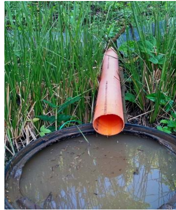
Figura 15. Colector de suelo erosionado
