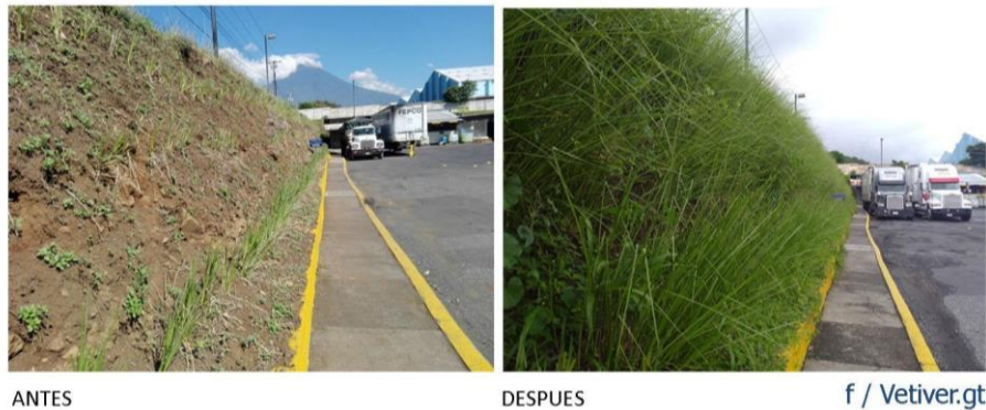
Figura 8. Protección de taludes de la erosión, ciudad de Guatemala (Ingeniería Viva, 2016)
