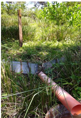
Figura 10. Conducción de suelo erosionado
