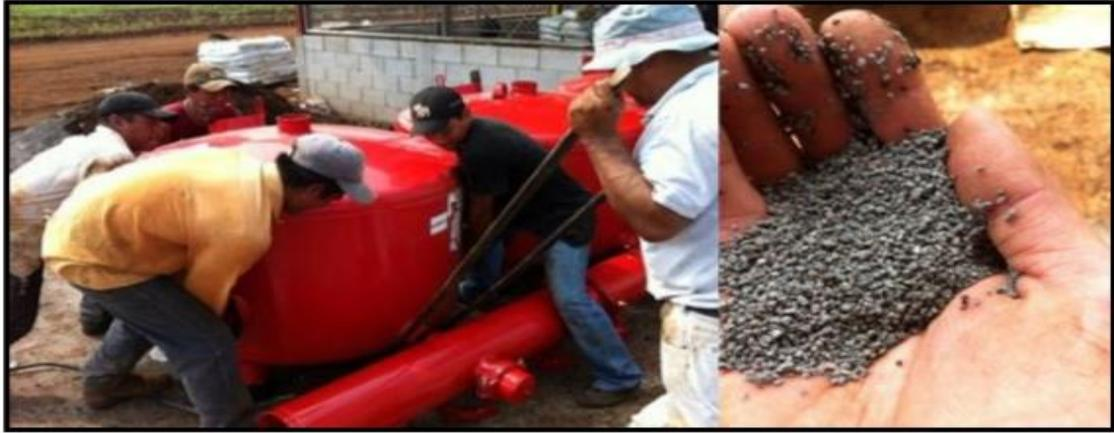
Figura 11. Instalación de los filtros de grava y el medio filtrante (Franco, 2014).
