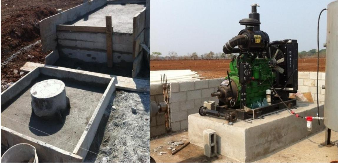
Figura 6. Base cementada para colocación de motor.
