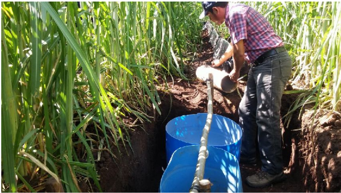
Figura 16. Colectores de agua escorrentía. Fuente: autor
