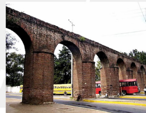
F3. Ingreso Avenida Hincapié
