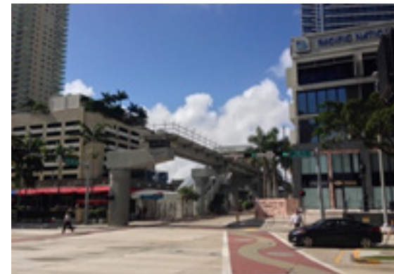
ILUSTRACIÓN 13. VIALIDAD. ESTACIÓN DEL MONORRIEL EN BRICKELL AV.
