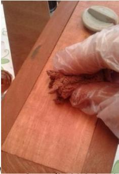
*Imagen N°.54. Aplicación de tinte y sellador a base de agua.*
