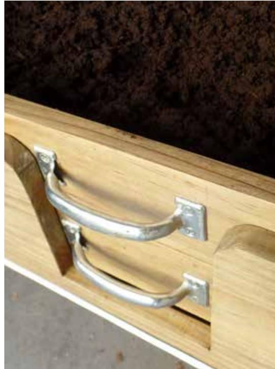
El prototipo tiene dos agarradores de cada lado para que dos personas puedan agarrarlos y así mover las cajas con el peso distribuido para no lastimarse a la hora de realizar el trabajo por cargar mucho peso.
