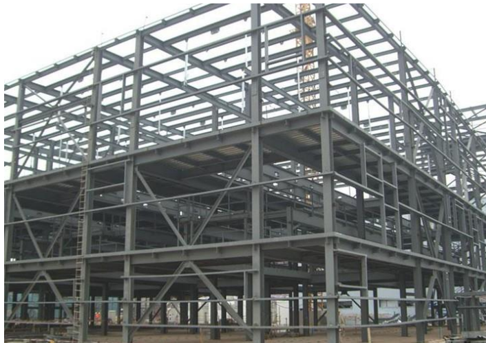
Estructura de acero edificios
