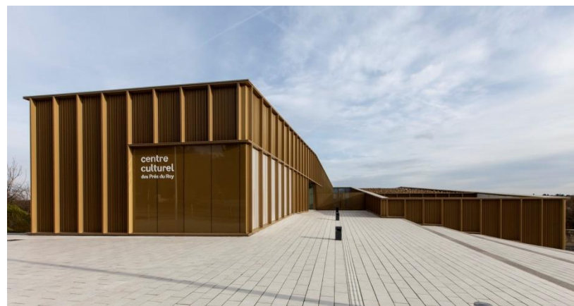
Imagen 47 Fachada principal Centro Cultural. Fuente: http://www.plataformaarquitectura.cl/cl/763545/centro-cultural-en-saint-germain-les-arpajon-ateliers-o-s-architectes
