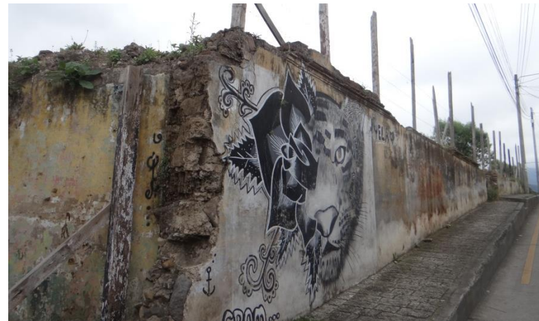
Imagen 68 Detalle de muro perimetral de adobe y piedra del terreno. Fuente: Luisa Noguera
