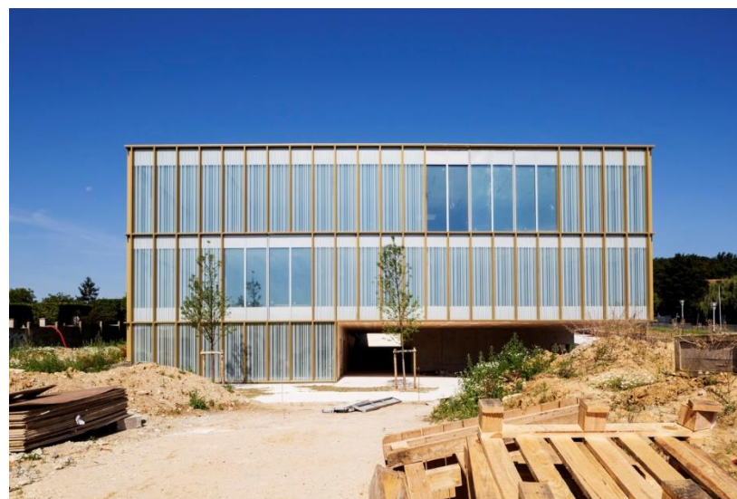
Imagen 46 Fachada lateral Centro Cultural. Fuente: http://www.plataformaarquitectura.cl/cl/763545/centro-cultural-en-saint-germain-les-arpajon-ateliers-o-s-architectes
