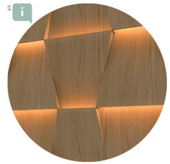
Los muros del auditorio tienen cubierta de paneles de madera para un mejor desarrollo acústico. El piso también es de madera debido a que este es un material con propiedades acústicas ideales que trabaja como un aislante de sonido. Fuente de imagen: http://bit.ly/2EQsTfk
