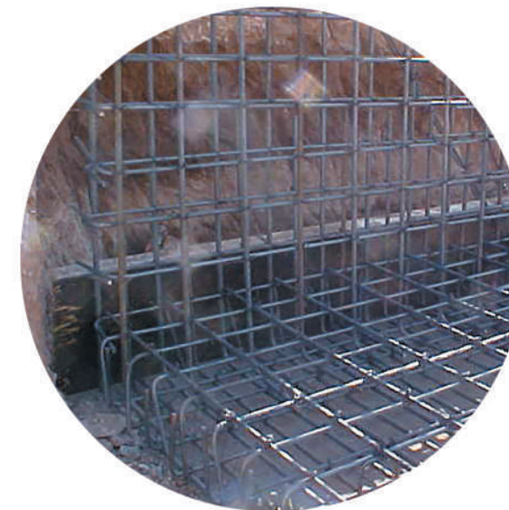
Imágenes ilustrativas del proceso constructivo de muros de contención. Fuente de imágenes: http://bit.ly/2oMlvqh (izquierda) y http://bit.ly/2D3kgN8 (derecha).
