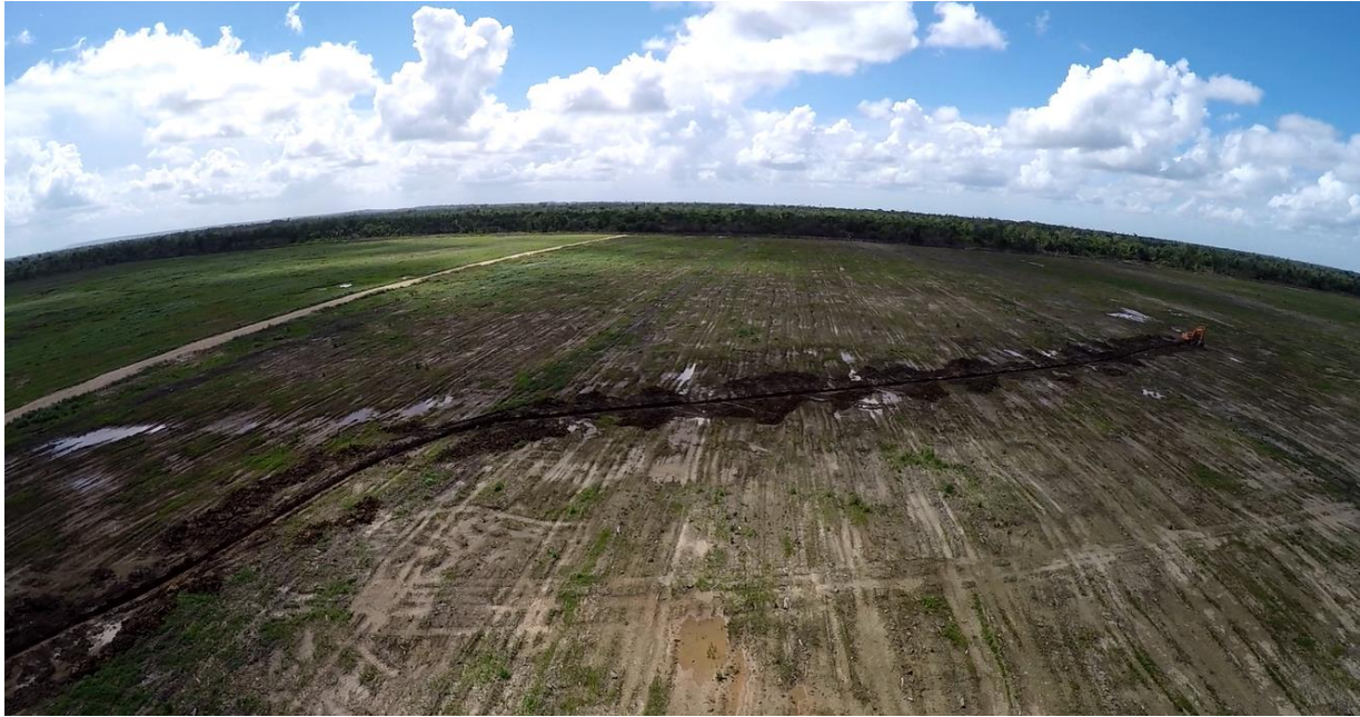
Figura 16. Construcción del canal que se encuentra entre la ZONA A y ZONA B y que se encarga de recolectar y drenar el agua de ambas.
