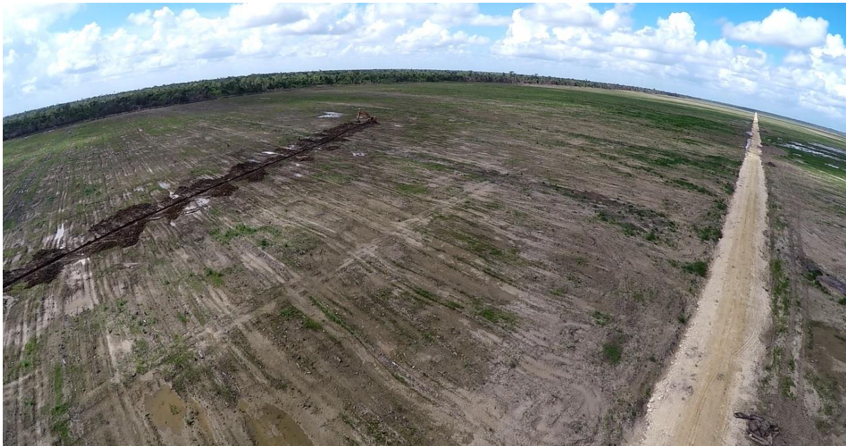
Figura 17. Construcción del canal que se encuentra entre la ZONA A y ZONA B y que se encarga de recolectar y drenar el agua de ambas.
