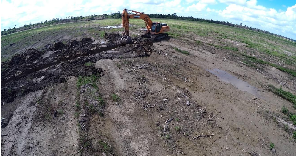
Figura 18. Excavadora utilizada para hacer el canal de drenaje entre las zonas A y B.
