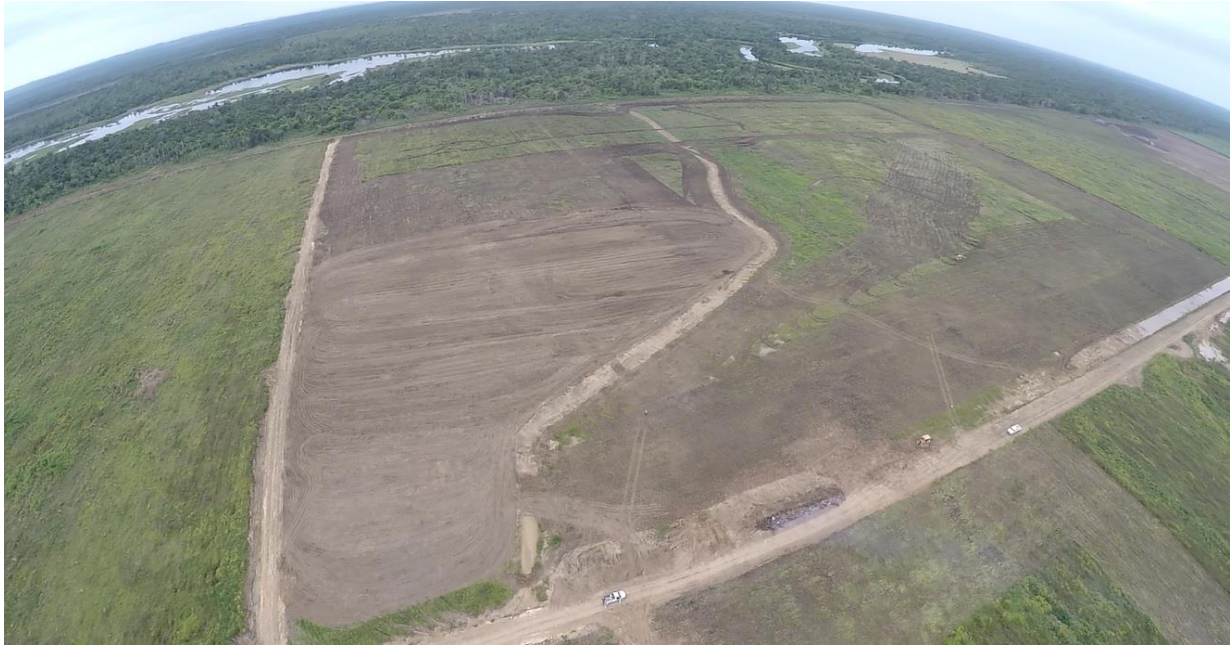
Figura 22. Campo 17 previo a la nivelación al realizar el pasado de rastra.
