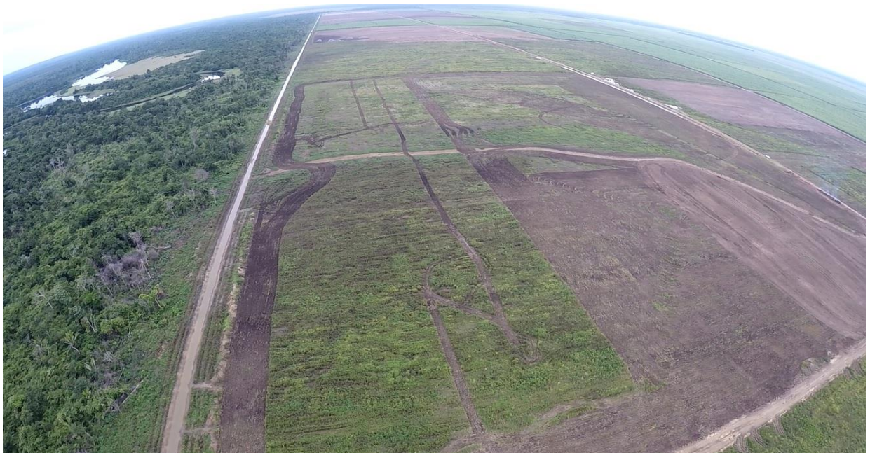
Figura 21. Campo 17 previo a la nivelación al realizar el pasado de rastra.
