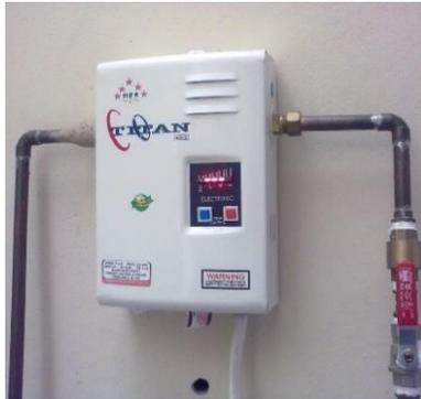
*Ilustración 9: calentador de paso instantáneo.*
