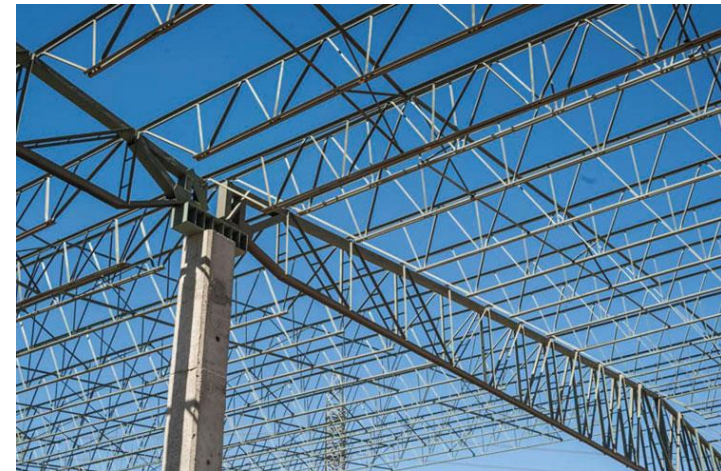
EJEMPLO DE ESTRUCTURA TIPO JOIST
