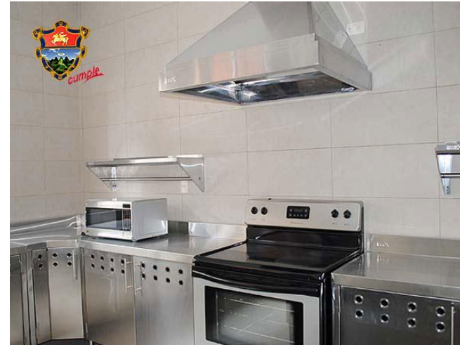
FIG. 51, ACABADOS , nuevas instalaciones para bomberos municipales, (2010). Tomado de: http://gt.muniguate.com/details.php?image_id=61108
