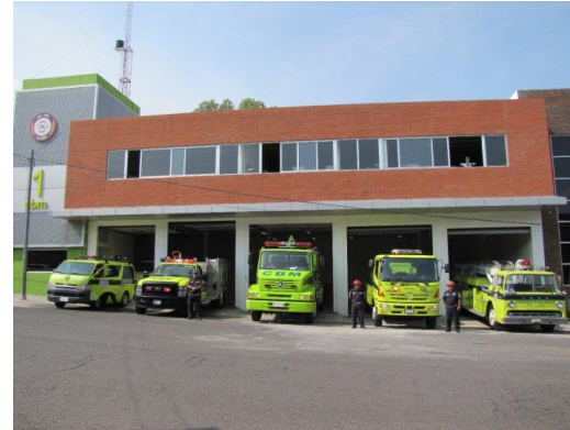
FIG. 106, ESTACIÓN DE BOMBEROS , fuente propia.
