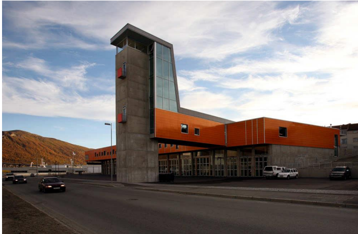
FIG. 18, VISTA , Raanes, Bent (2010), Duque, Karina. Estacion de bomberos, Tomado de: http://www.plataformaarquitectura.cl/2011/02/04/estacion-de-bomberostroms%C3%B8-stein-halvorsen-sivilarkitekter/
