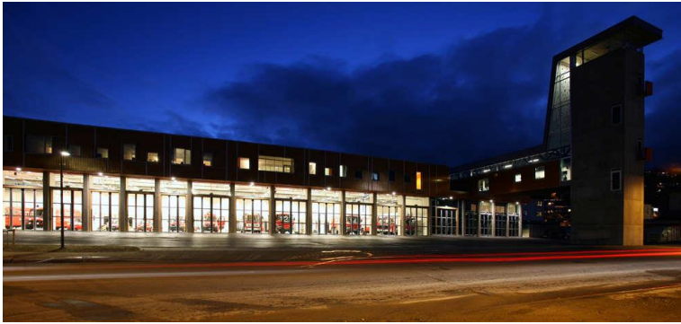
FIG. 21, VISTA , Raanes, Bent (2010), Duque, Karina. Estacion de bomberos, Tomado de: http://www.plataformaarquitectura.cl/2011/02/04/estacion-de-bomberos-troms%C3%B8-stein-halvorsen-sivilarkitekter/1292531775-034/
