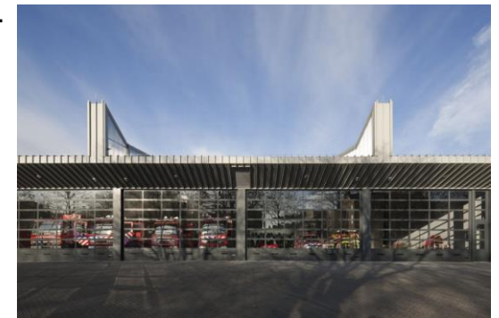
FIG. 13, FACHADA , Scagliola, Daria (2010), Concha, Alejandro. Estación de bomberos Rijswijk, Tomado de: http://www.plataformaarquitectura.cl/2010/12/26/estacion-de-bomberos-rijswijk-jeanne-dekkers-architectuur/jeanne-dekkers-architectuur-%C2%A9-daria-scagliola-stein-brakkee-3/
