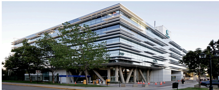
Fig. 43: Vista a nivel de calle del edificio.
