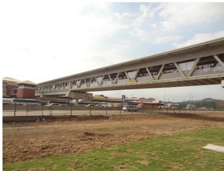
Fuente: Dream)Liner25. (2008). Pasarela de Albrook [Fotografía]. Recuperado en http://www.skyscrapercity.com/showthread.php?t=1433647&page=569
