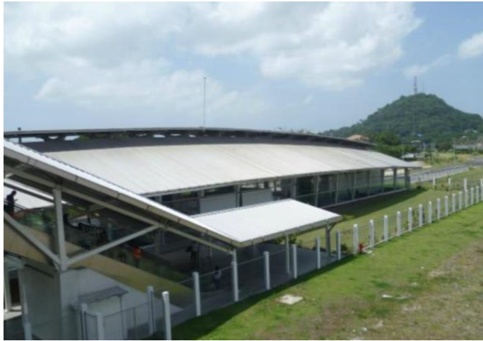
Fuente: Dream)Liner25. (2008). Exterior de Estación Albrook [Fotografía]. Recuperado en http://www.skyscrapercity.com/showthread.php?t=1433647&page=569
