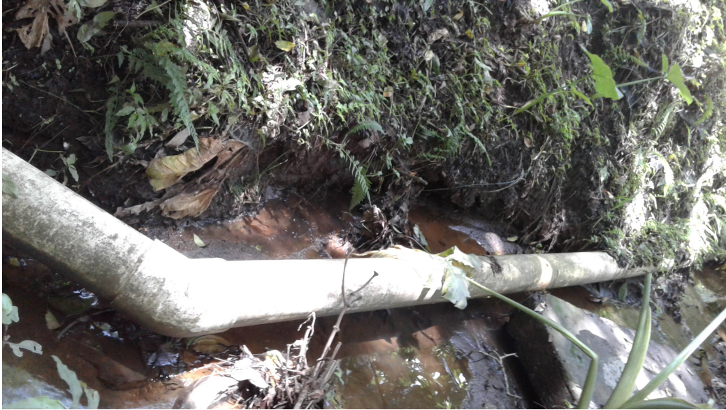
Figura 25. Agua estancada y contaminada en zanjas de tubería, Ciénega II.
