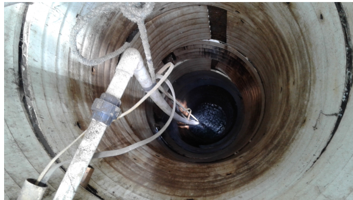
Figura 25. Agua estancada y contaminada en zanjas de tubería, Ciénega II.
