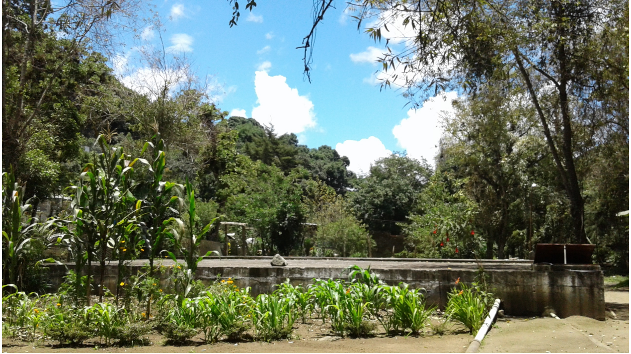
Figura 28. Tanque de almacenamiento, Ciénega I.
