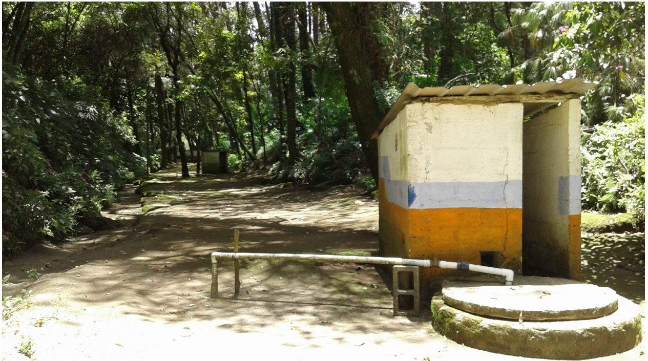
Figura 20. Terreno Sistema de abastecimiento de agua potable Ciénega I.
