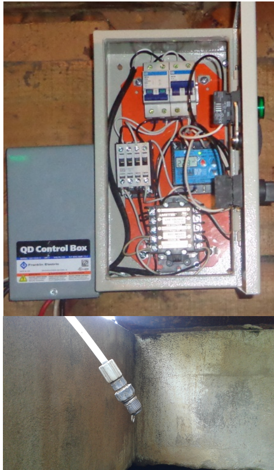
Figura 30. Dosificador de cloro para el sistema Las Ciénegas.
