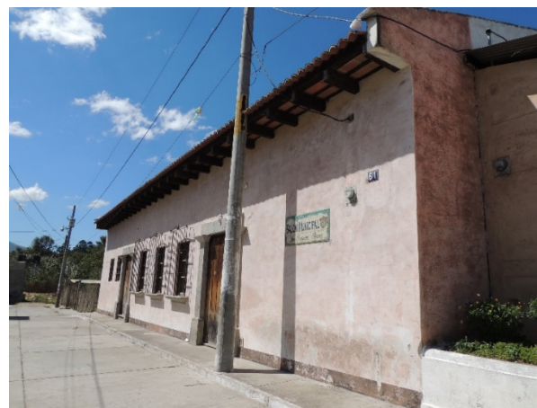
Salon Comunal San Bartolome. San Bartolome Becerra. (2014). Fuente: Fotografía Propia
