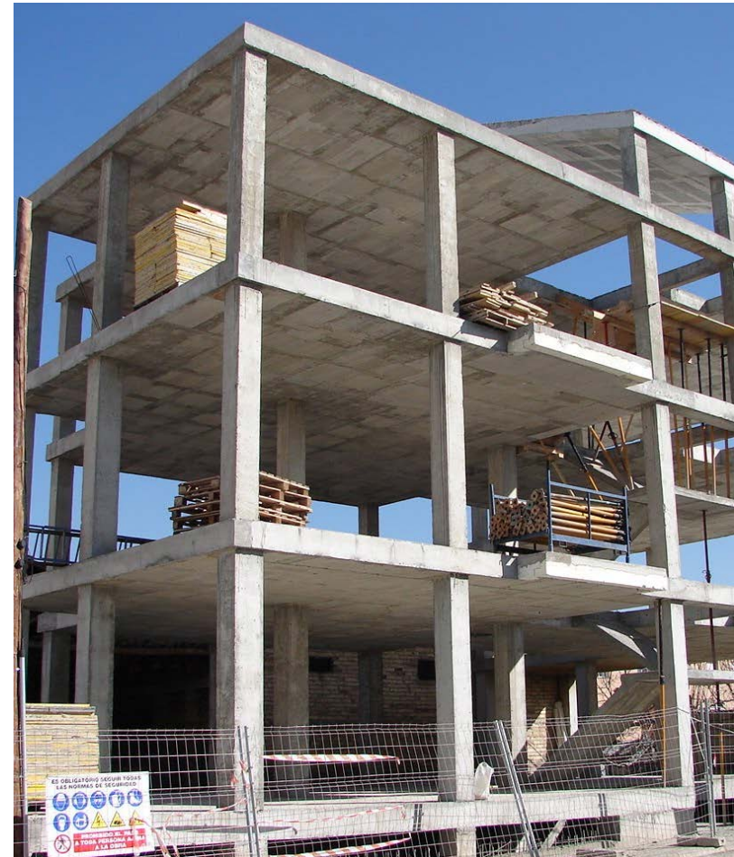
INGENIERIA Y CONSTRUCCION (2013). Comportamiento de diferentes tipos de sistemas estructurales en terremotos. Recuperado http://1.bp.blogspot.com/_rYfxCeAmsw/TB3cxEiN8cl/AAAAAAAAACM/I6GfXOjenc/s1600/DSC02914.jpg
