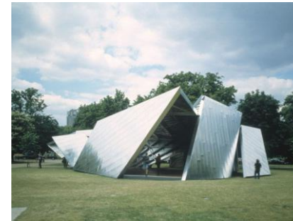
Pabellón en casa arquitectónica.
