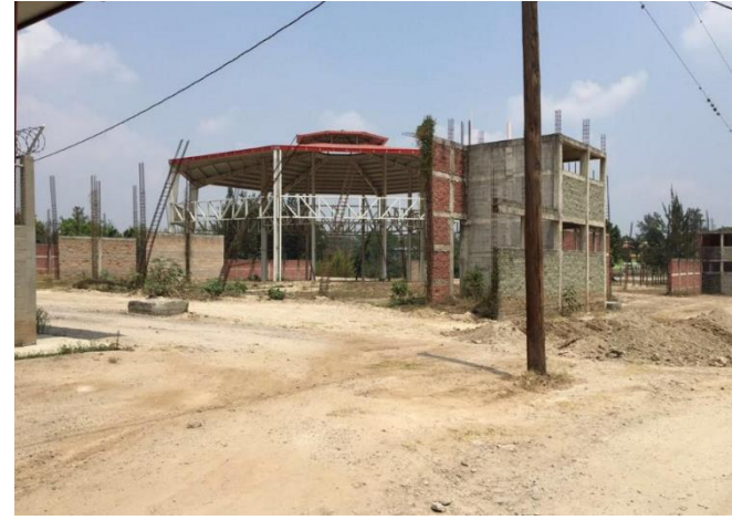
Construcción existente en el acceso de salida.
