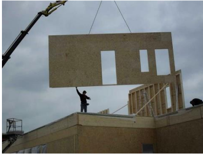
Ensamblaje de muro prefabricado.
