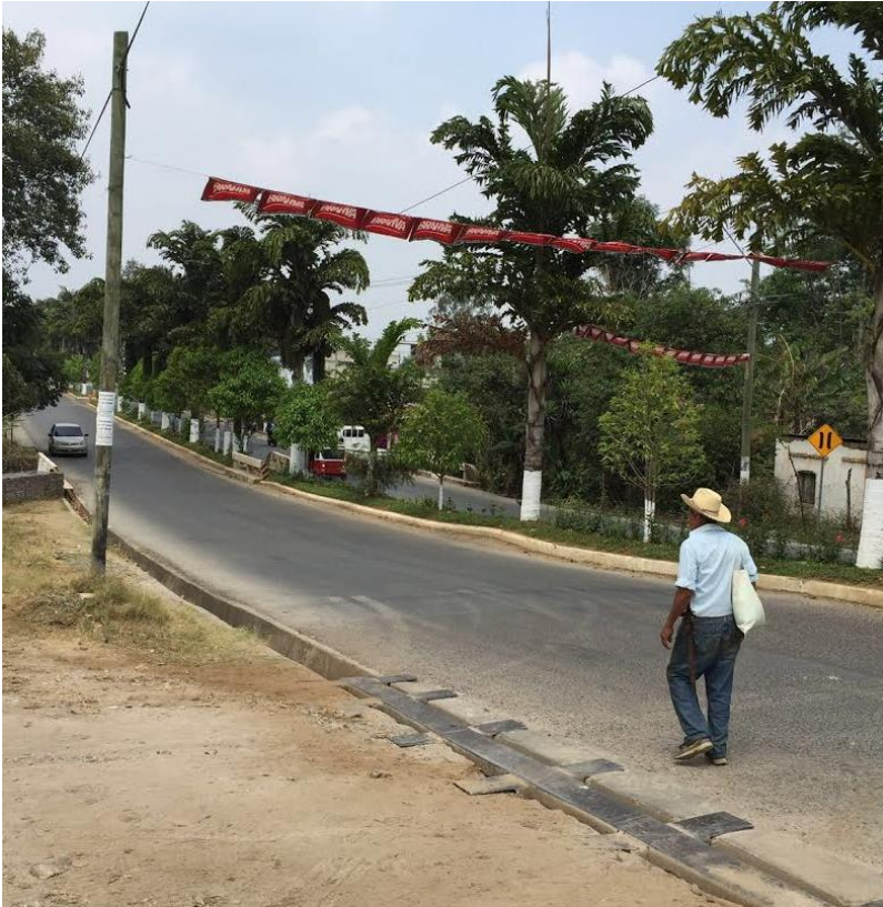
Carretera asfaltada que conecta al ingreso principal del terreno.
