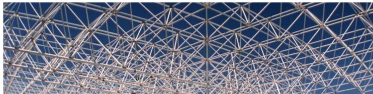
Estereoestructura. Fuente: [http://www.fapym.com/sitio/images/header\\_estereo\\_estructuras.jpg](http://www.fapym.com/sitio/images/header_estereo_estructuras.jpg) (2016)
