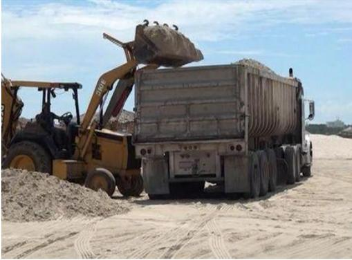
Estas máquinas tienen como funciones principales las de cargar en las unidades de transporte materiales sueltos o la alimentación de tolvas, acopiar productos, efectuar operaciones de excavación en terrenos no muy duros o compactos, elevación y manejo de cargas y acarreos a distancias pequeñas de materiales (no más
