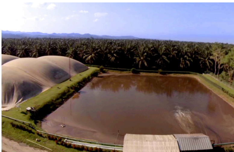
Figura 8. Lagunas carpadas para la captura de metano y laguna facultativa.
