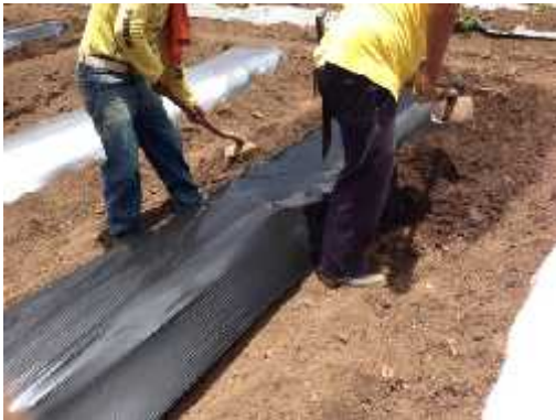
Figura 8. Colocación de acolchados
