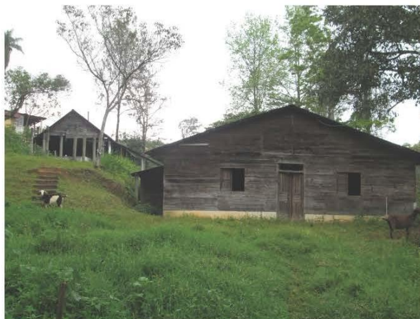
Primer edificio de Fundemi Talita Kumi, construido aproximadamente en los años setenta, en la Comunidad Tzunutz, municipio de Carchá, A.V.
