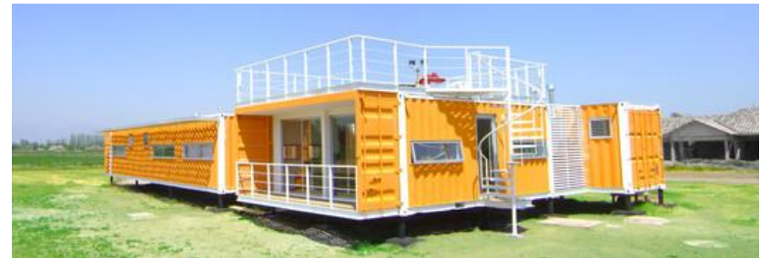
Ilustración 7: Fachada Noroeste Casa Liray (ARQtainers, 2011).
