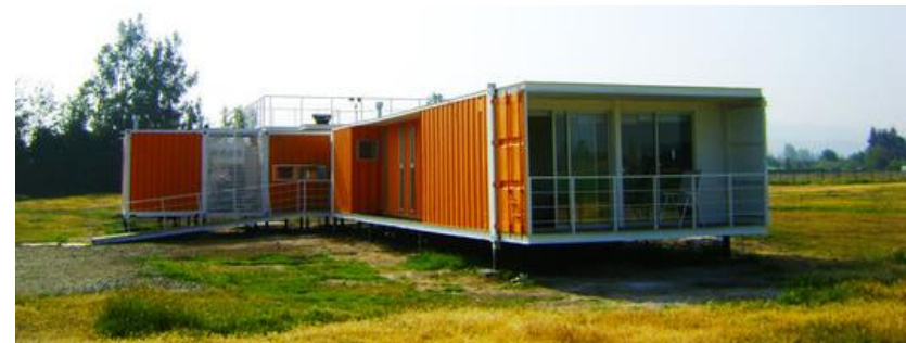
Ilustración 8: Fachada Noreste Casa Liray (ARQtainers, 2011).
