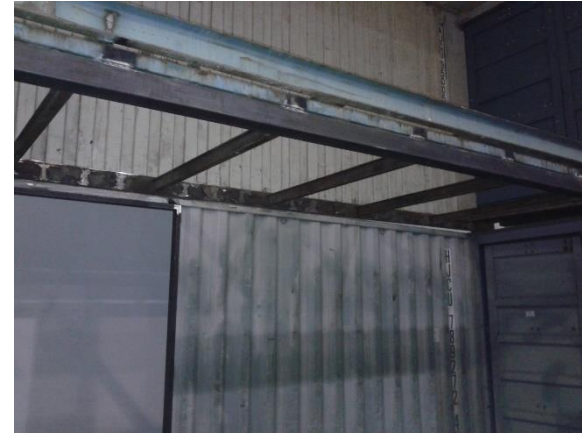
Ilustración 33: Tipo de refuerzo horizontal (Tercera Piel, 2012)
