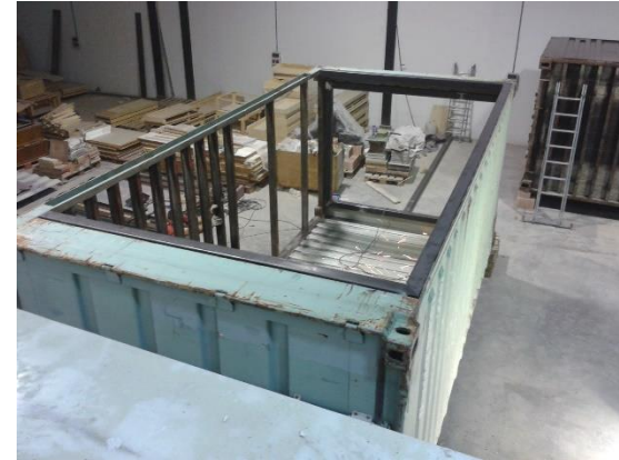
Ilustración 32: Tipo de refuerzo vertical (Tercera Piel, 2012)
