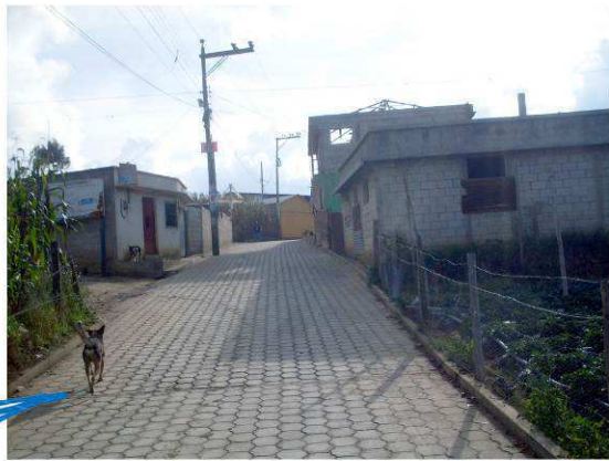
CALLE PRINCIPAL (TRAMO ADOQUINADO)
