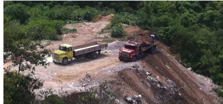
Fotografía 16. Vista aérea del sitio y actividades clandestinas que se realizan ilegalmente
