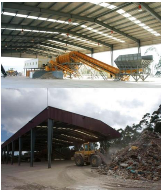
Fotografía 7. Instalaciones de planta Cogersa, España.
