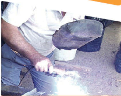
PROCESO DE UNIÓN CON SOLDADURA
