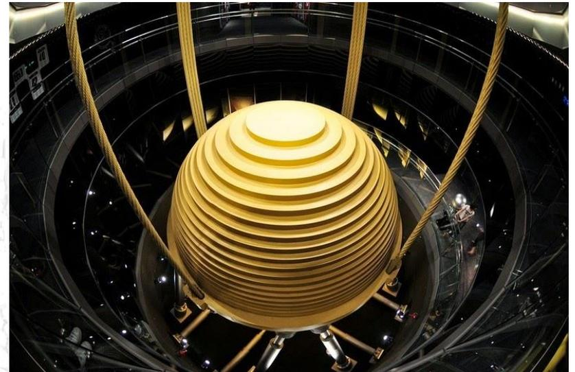
Ilustración 57 - Amortiguador de masa Taipéi (Amusing Planet, 2010)
