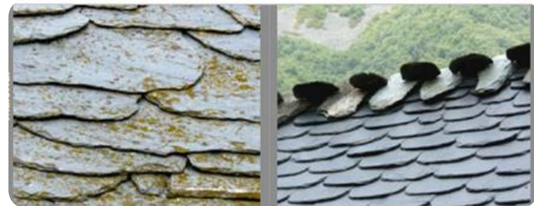
Figure 34 Cubierta de piedra
