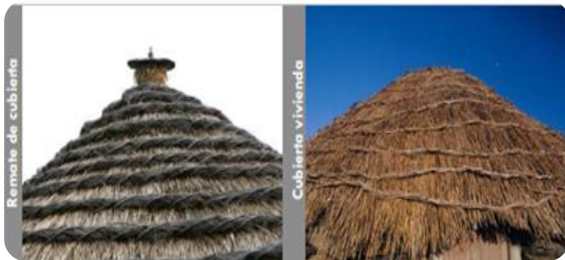
Figure 37 Cubierta de paja
