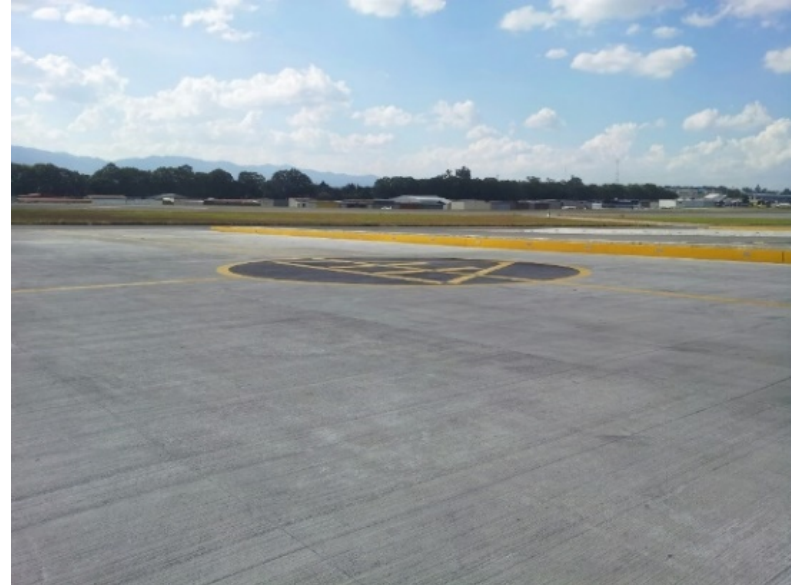
“fuente propia” – aeropuerto la aurora
