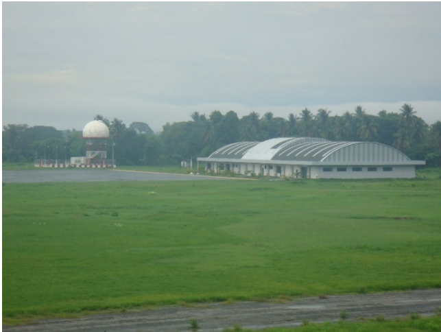
Edificación, Aeropuerto de San José, Escuintla
