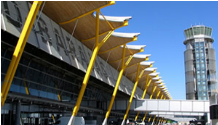
Estructura del aeropuerto – vista exterior
