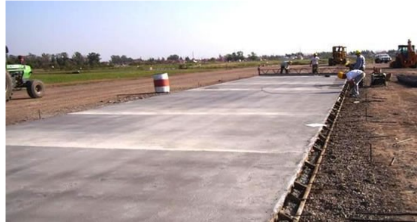
Ejecución de pavimento para pista de despegue y aterrizaje
