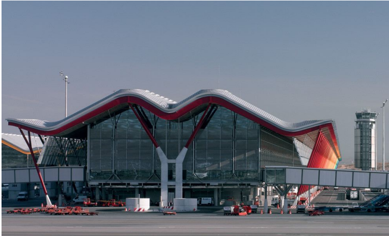
Vista exterior de aeropuerto – degradación de colores en fachada
