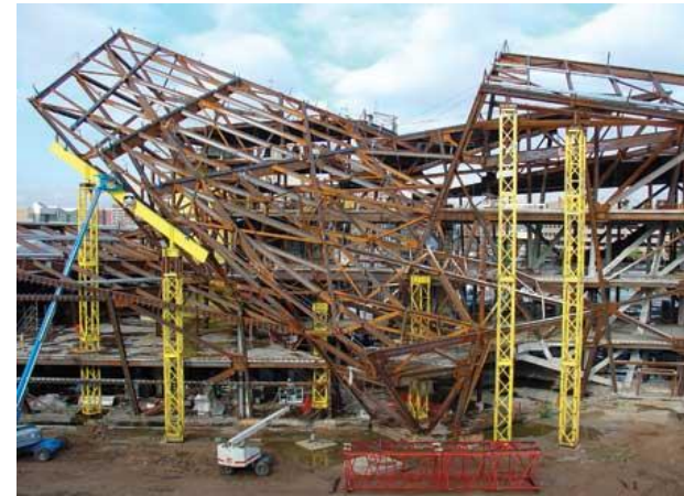
Estructura del edificio en obra Fuente: http://www.structurearchives.org
