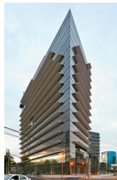
Edificio Design Center (2008) Fuente: http://www.inspecciones-globales.com
