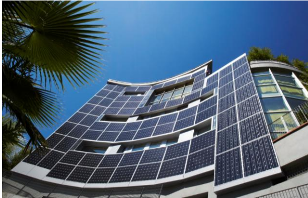
Fachada fotovoltaica en un edificio Fuente: http://www.arquitecturainteligente10.com
