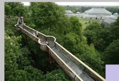
Xstrada treetop walkway en Reino Unido.
