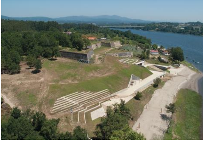
Fuente : Pablo Gallego Picar Imagen 22: Vista aérea del proyecto terminado.
