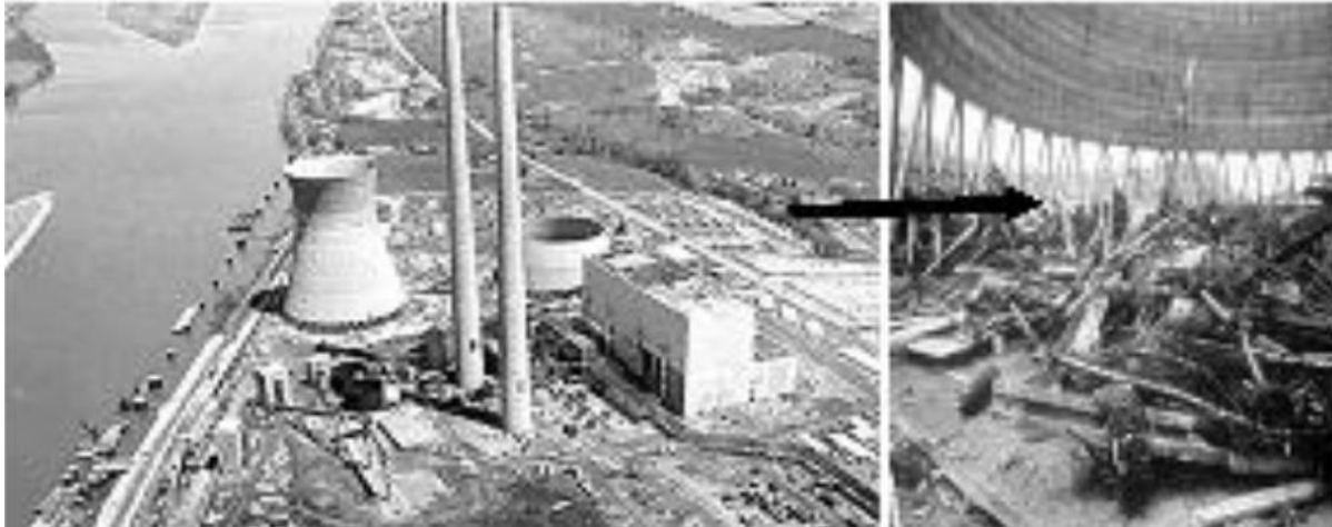
Figura 4: Colapso de la torre de enfriamiento debido a la aplicación de cargas de construcción aplicadas a edades tempranas.
