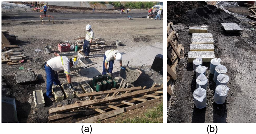
Figura 50: Pruebas al concreto fresco y especímenes (a) y especímenes cilíndricos y de vigas recién terminados (b).
