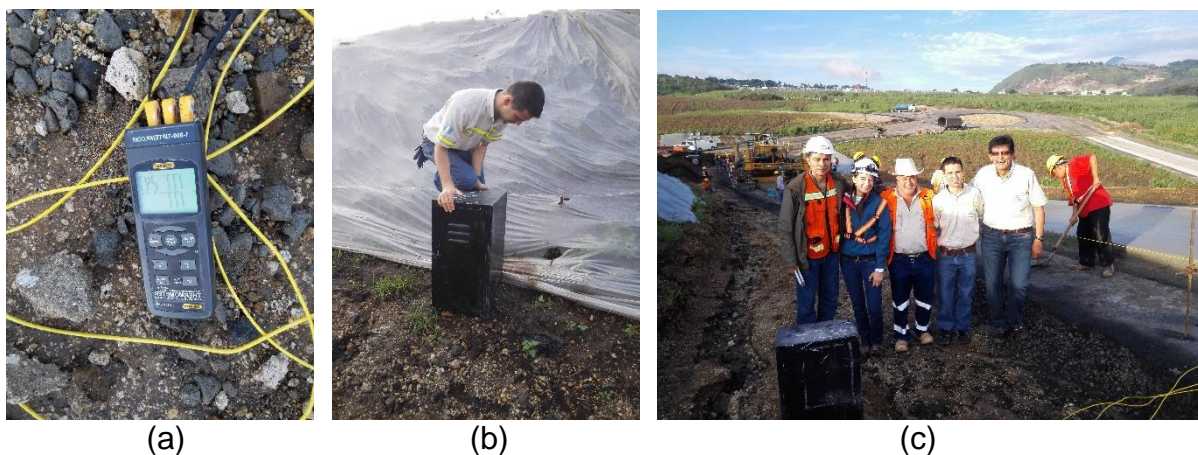
Figura 49: Dispositivo de recolección de datos (datalogger) (a), colocación del locker y datalogger (b) y miembros del equipo de proyecto en la instalación de los sensores (c).
