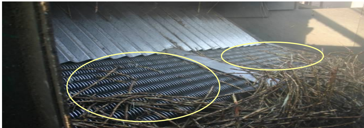
Figura 11. Tamiz móvil funcionando como separador de material sólido
