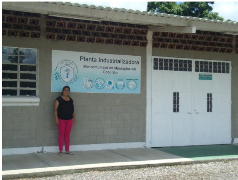
Figura 14. Planta Industrializadora Mancomunidad de Municipios del Cono Sur.
