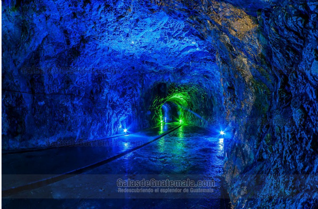
Imagen 8: Túnel de Hidroeléctrica Chixoy, Alta Verapaz Fuente: Mynor Mijangos. www.galasdeguatemala.com
