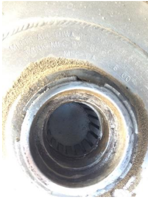
Imagen 40 – Descripción: Rejilla en tanque de diésel –Fuente: propia
