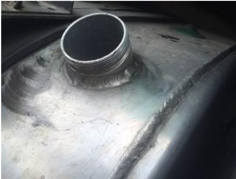
Imagen 25 – Descripción: Boca de tanque de diésel – Fuente: Propia
