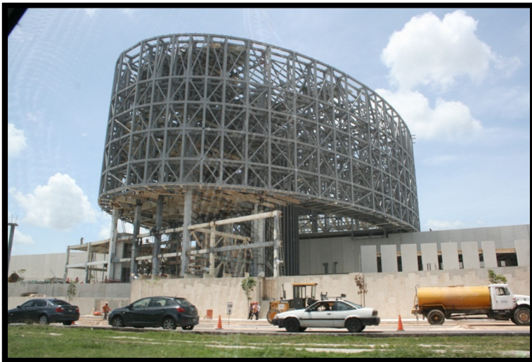
Proceso de construcción del museo.
