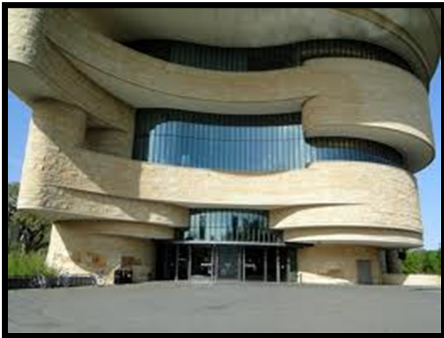
Vista exterior del ingreso.
