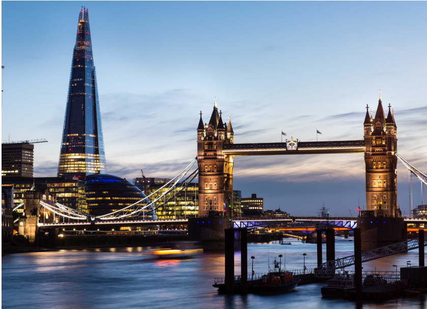
Iluminación natural tenue y artificial continua Hotel The Shard - Londres Fuente: http://www.shangri-la.com/london/shangrila/
