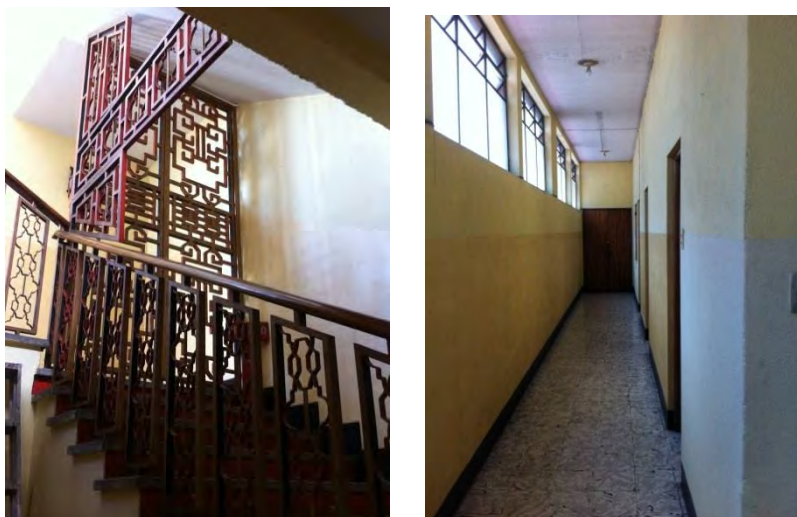
Gradas hacia Segundo Nivel y Bodegas en Segundo Nivel
