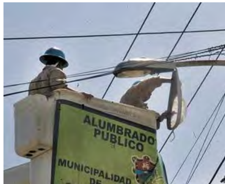
Servidores municipales cambiando luminaria
