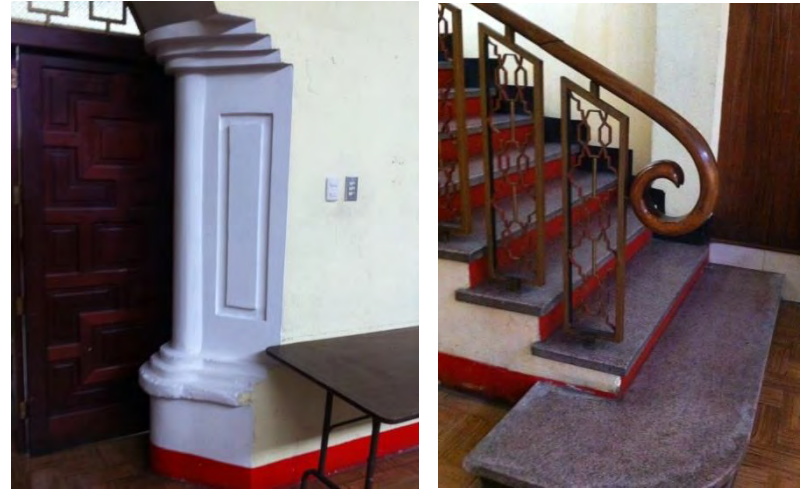
Detalle de Arco con Columna y Gradas Fuente: Propia Fecha: marzo 2013
