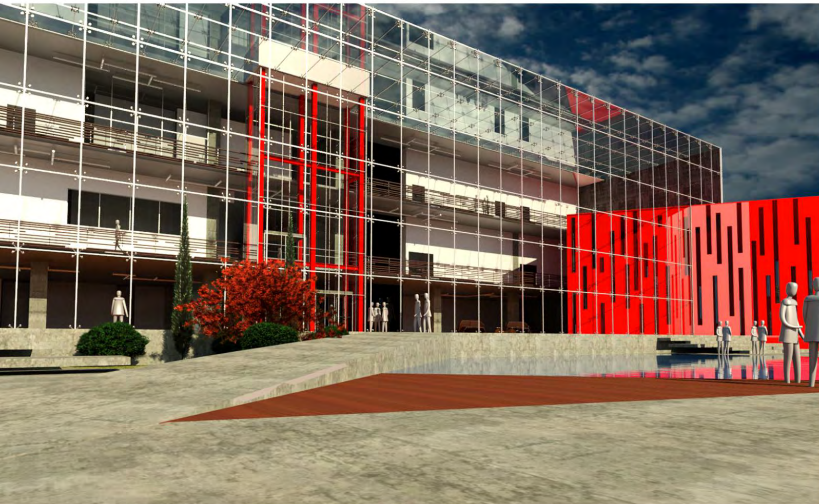
ACCESO HACIA EDIFICIO PRINCIPAL
