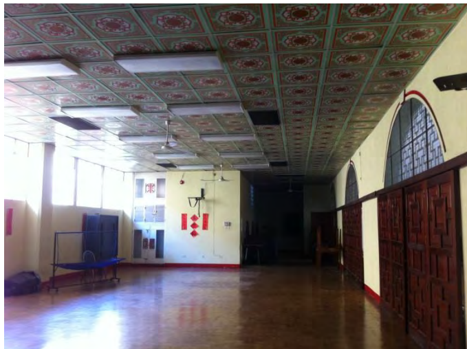
Salón Secundario en área de Ampliación
