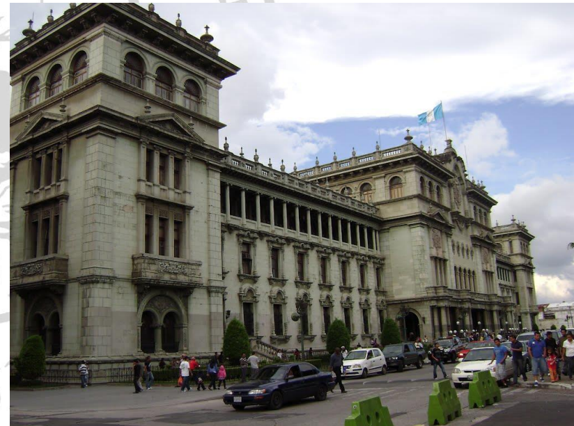
ILUSTRACIÓN 26: Palacio Nacional de la Ciudad de Guatemala FUENTE: Fotografía por Mario Pumacayo. (Guatemala. 2012). Disponible en: http://www.panoramio.com/photo/77556426 .
