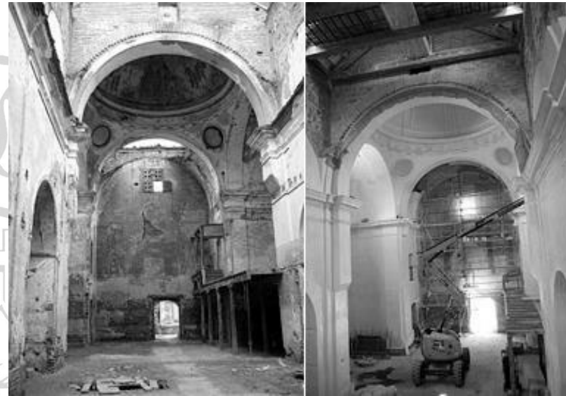
ILUSTRACIÓN 61: Antigua Alfar del Carmen en Talavera de la Reina, España, antes y después de los trabajos de Restauración
