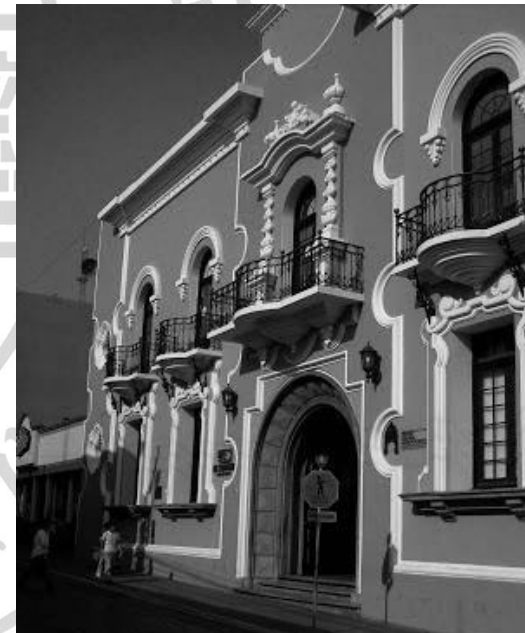
ILUSTRACIÓN 65: Edificio de Correos, Centro Histórico. FUENTE: Fotografía por Edgar Rodríguez. (Guatemala. 2008). Disponible en: http://echandoflores.blogspot.com/2008/04/edificio-de-correos-de-guatemala.html .
