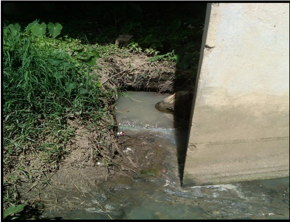
Figura 14. Salida de drenaje municipal de aguas residuales
