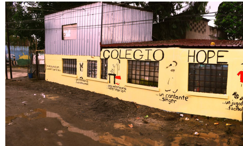
Instalaciones del Colegio HOPE, ubicadas en el Asentamiento de la Línea Férrea, zona 12, Ciudad de Guatemala. > Fuente: https://www.facebook.com/photo.php?fbid=498703116820857&set=a.278673332157171.73988.121066421251197&type=3&theater
