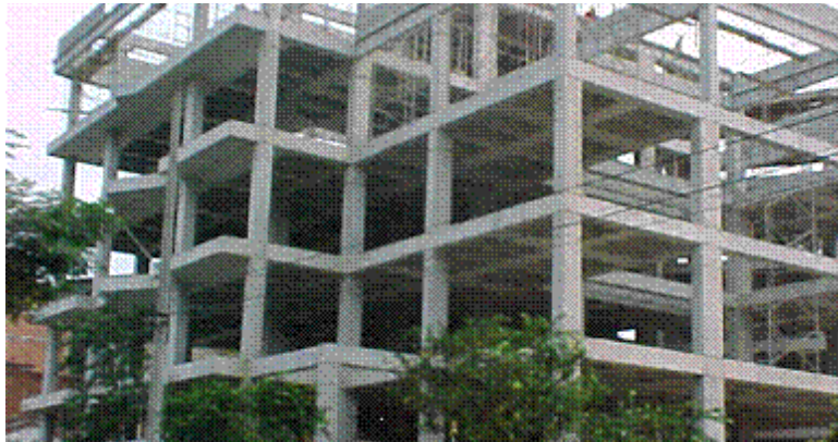
35. Estructura de marcos. Fuente: estructuras.eia.edu.co
