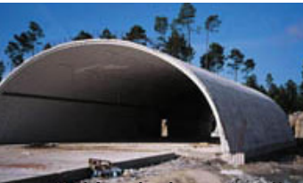
fundición de losa tradicional con forma curva
