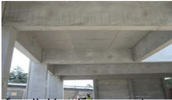
fundición de concreto armado
