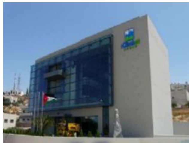
48. Fachada exterior de rocódromo :climbat Jordania. Fuente: recuperado en abril de 2011 de: http://desnivel.com/escalada-roca/rocodromos/noticias
