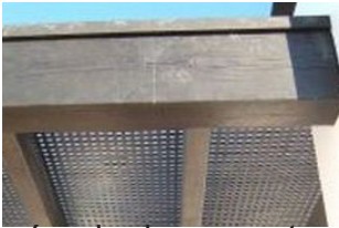
pérgola de concreto + cubierta
