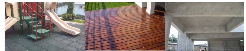
baldosa de caucho reciclado para exterior deck de madera tratada para exterior fundición de concreto armado
