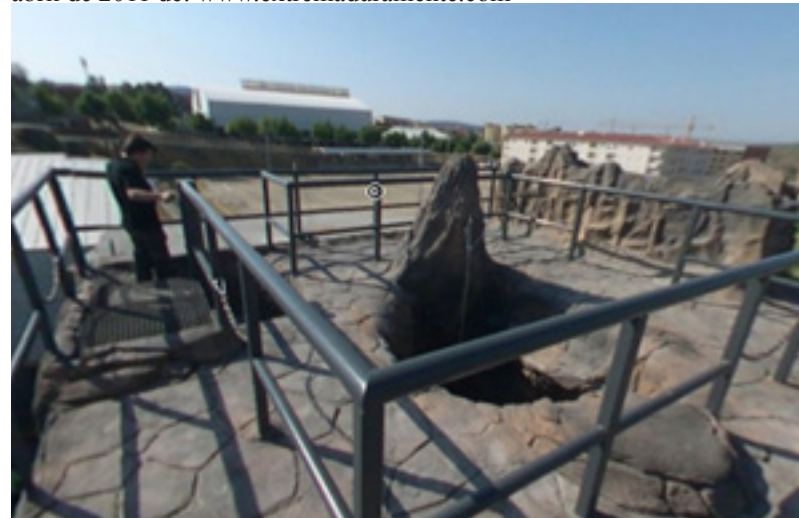
76. Vista desde área superior de muro chimenea. Fuente: recuperado en abril de 2011 de: www.extremaduramente.com
