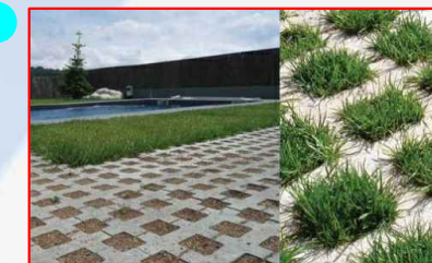
FOTOGRAFIA No.23 ADOQUIN DE HORMIGÓN DECORATIVO Y RESISTENTE PARA PARQUEOS DICHO ADOQUIN SE UTILIZARA EN AREAS DE PARQUEOS PARA CREAR ESPACIOS MAS VERDES Y A SI EVITAR LA LARGAS PLANCHAS DE CONCRETO QUE AFECTAN AL AMBIENTE, COMO TAMBIEN DRENAR EL AGUA DE LLUVIA QUE SE GENERE EN DETERMINADA TEMPORADA, ASI TAMBIEN CREAR ESPACIOS QUE NO GENEREN MUCHO MANTENIMIENTO PARA EVITAR COSTOS. JUNIO 2012
