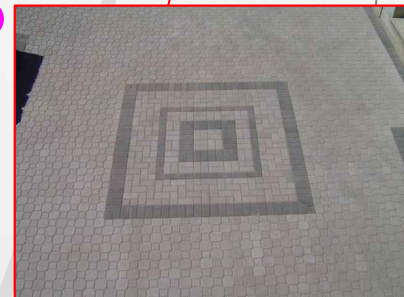
FOTOGRAFIA No. 19 ADOQUIN DE HORMIGÓN DECORATIVO Y RESISTENTE PARA CAMINAMIENTOS DICHO ADOQUIN SE UTILIZARA EN AREAS DE CAMINAMIENTOS DONDE SE QUIERE REALZAR LA BELLEZA NATURAL, CREAMDO ESPACIOS CAUTIVANTES. DICHO DISEÑO VARIA SEGUN UBICACIÓN. JUNIO 2012
