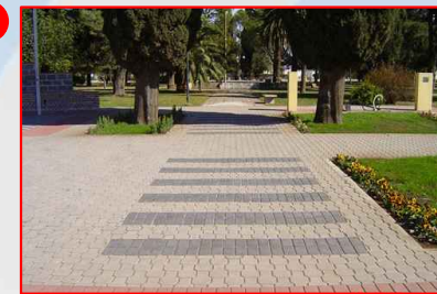
FOTOGRAFIA No. 21 ADOQUIN DE HORMIGÓN DECORATIVO Y RESISTENTE PARA CAMINAMIENTOS DICHO ADOQUIN SE UTILIZARA EN AREAS DE CAMINAMIENTOS DONDE SE REQUIERA SEÑALIZACIÓN DE DIRECCIÓN DE PASO DE PEATONES. JUNIO 2012
