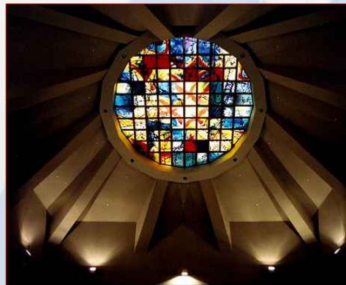
FOTOGRAFIA No. 26 VITRALES FOTOVOLTAICOS DE COLORES ESTOS SE COLOCARAN EN EL TECHO DEL ATRIO, LOS CUALES PERMITIRÁN GENERAR ENERGÍA, DEBIDO A QUE ES LA PARTE MÁS ALTA DEL CENTRO DE TUTORÍAS, LA QUE SE APROVECHARÁ YA QUE TENDRA UNA FUENTE DIRECTA CON EL SOL, ESTE TIPO DE SISTEMA TIENE UNA VIDA ÚTIL LARGA ,Y GENERA POCO MANTENIMIENTO, LO QUE SE BUSCA EN EL CENTRO, PARA EVITAR GASTOS, ADEMÁS CON LA GAMA DE COLORES EXISTENTE SE APROVECHARÁ PARA GENERAR COLOR EN ÁREA DE ATRIO. FEBRERO 2014 Fuente: http://www.masters-energia-solar.com/2013/08/vitrales-fotovoltaicos-para-catedral-en.html
