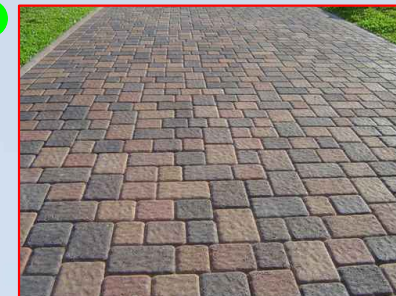
FOTOGRAFIA No. 22 ADOQUIN DE HORMIGÓN DECORATIVO Y RESISTENTE PARA CAMINAMIENTOS DICHO ADOQUIN SE UTILIZARA EN AREAS DE CAMINAMIENTOS DONDE SE QUIERE REALZAR LA BELLEZA NATURAL, CREAMDO ESPACIOS CAUTIVANTES. JUNIO 2012
