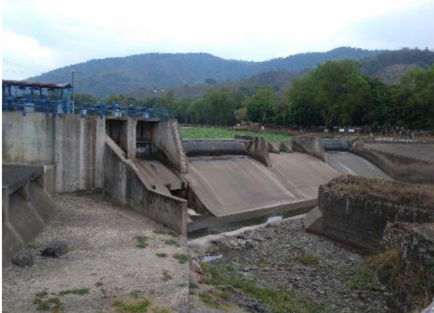
Figura 49. Hidroeléctrica Los Esclavos, ubicada dentro de la aldea Los Esclavos (Fuente: Mónica Rosales 15 abril 2018).
