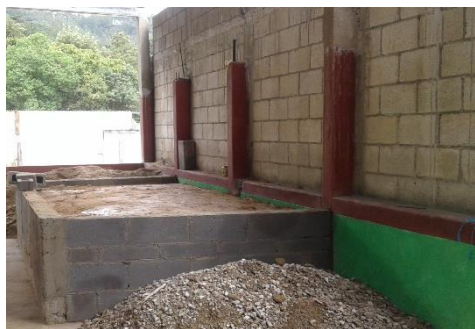
Fuente: Balan Camey, Cecilia (2017) Durante el proceso de construcción.
