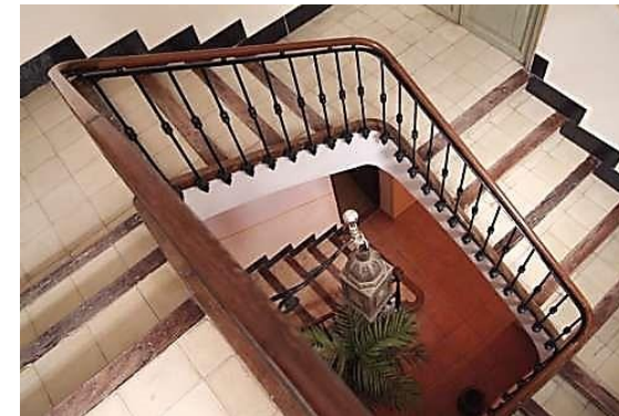
Imagen 3: Escaleras cuadradas Glosario Ilustrado de Arte arquitectónico.
