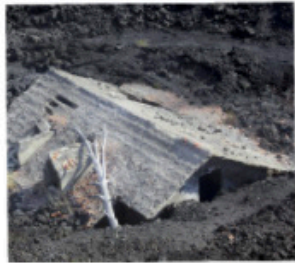
Casa soterrada por arena volcánica.
